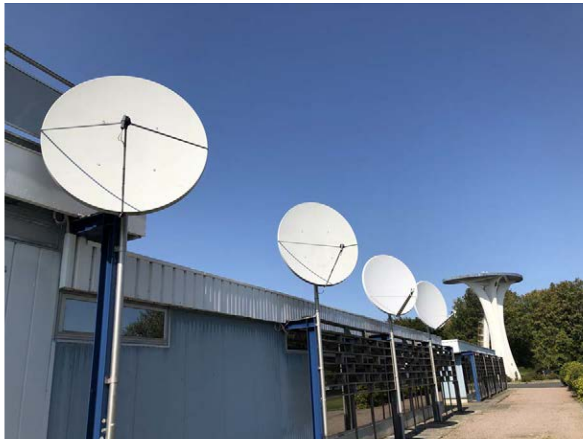
Les antennes A28, A29, A36 & A37 assurent la réception EUMETCast (diamètre : 1,80 m).
